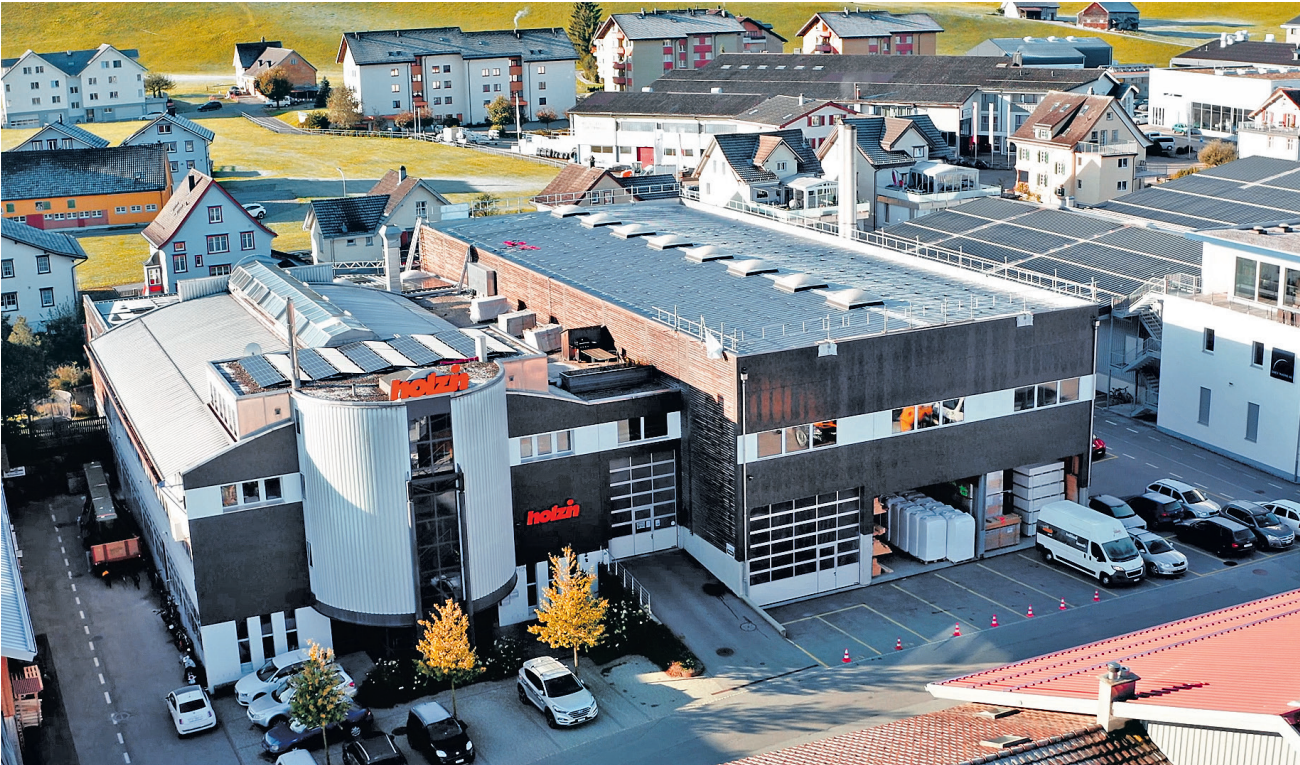
Der Wärmeverbund der Holzin AG zählt aktuell 48 Anschlüsse. (Bilder: zVg)
