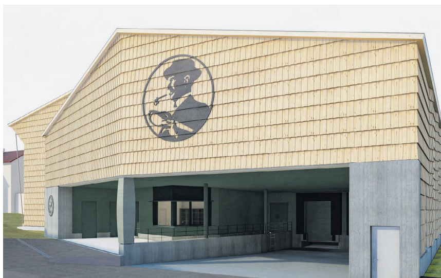
Die künftige Fassade aus grossen Holzschindeln bei der Appenzeller Alpenbitter AG. (Bild: zvg)
